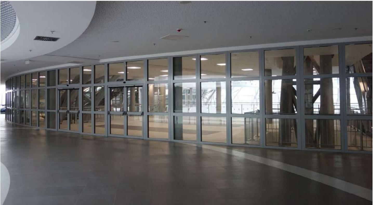
Le système **MB-118EI** est utilisé pour réaliser des cloisons coupe-feu intérieures, classées résistantes au feu EI 120. Ce système prévient également la propagation du feu (NRO). Sa structure est techniquement associée au système de cloisons coupe-feu avec porte **MB-78EI** en termes de composants communs: parclozes, matériaux de refroidissement, bandes intumescentes, joints d'étanchéité, accessoires, etc. La technologie de production et de montage est aussi la même.
